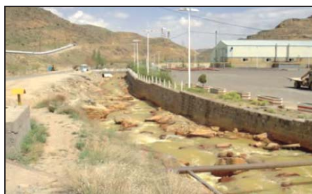
شکل ۱۰- زهاب خروجی از معدن، کدر و حاوی ذرات معلق آهن نبود جلبک‌ها
